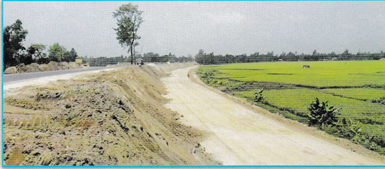
জয়দেবপুর - এলেঙ্গা মহাসড়কে সার্ভিস লেনসহ মহাসড়ক সম্প্রসারণের চলমানকাজ
