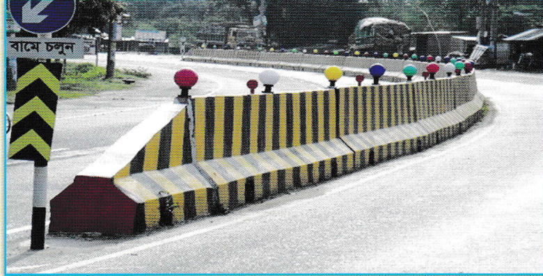
রোড ডিভাইডার নির্মাণ সহ সড়ক প্রশস্তকরণ
