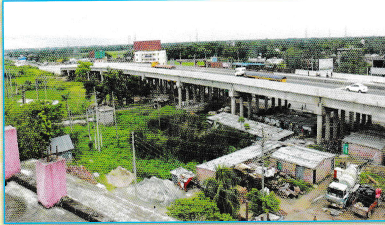
ঢাকা-চট্টগ্রাম মহাসড়কে কুমিল্লা রেলওয়ে ওভারপাস
